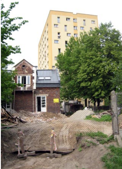
Fragment zabudowy osiedla Azory
