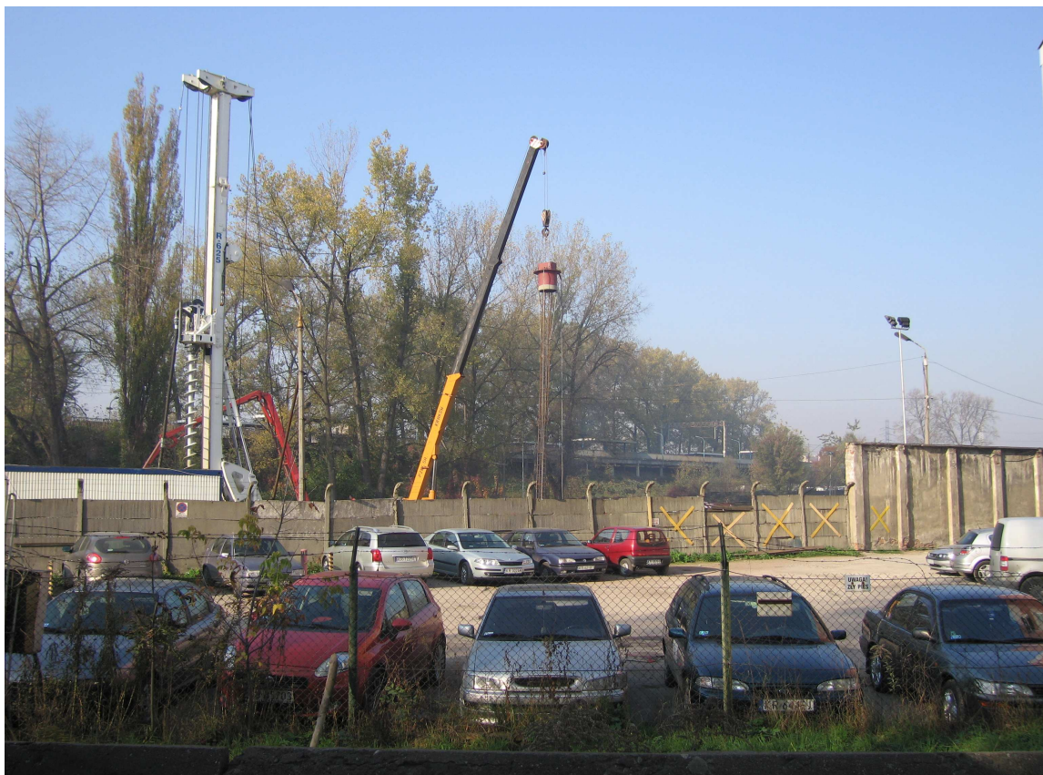
Budowa zespołu Garden Residence sąsiedztwie przystanku PKP Kraków - Zabłocie ( 2008)
