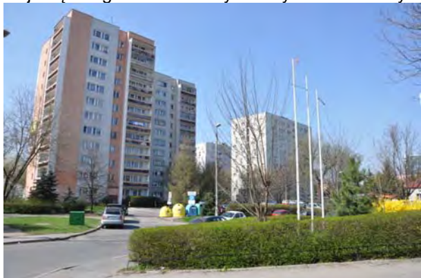
Fot. 15. Osiedle Olsza II – Sąsiedztwo II – punktowce, południowa granica sąsiedztwa
