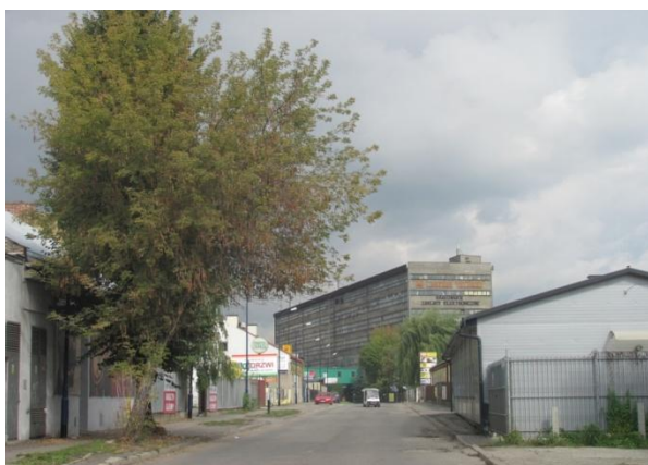
Zdjęcie 17. Stan techniczny zabudowy – ul. Romanowicza
