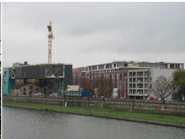
Zdjęcie 13. Budowa Muzeum Tadeusza Kantora
