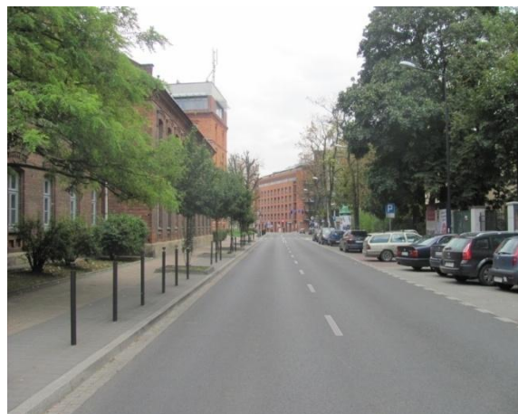
Zdjęcie 7. Przebudowana ul. Szlak
