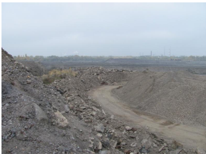
Zdjęcie 21. Zdegradowany teren – hałda odpadów hutniczych
