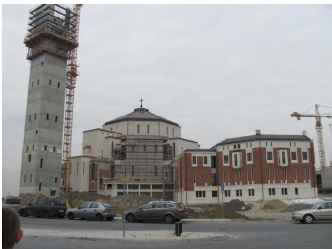
Zdjęcie 20. Budowa Centrum im. Jana Pawła II
